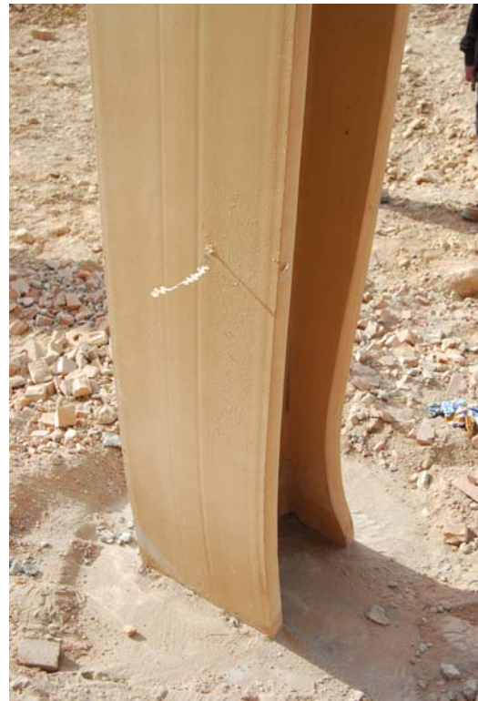
(d) Northwest view.
