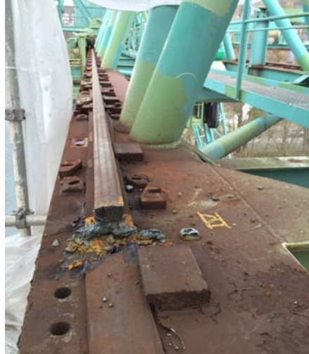
Ausbau der alten Fahrschienen
