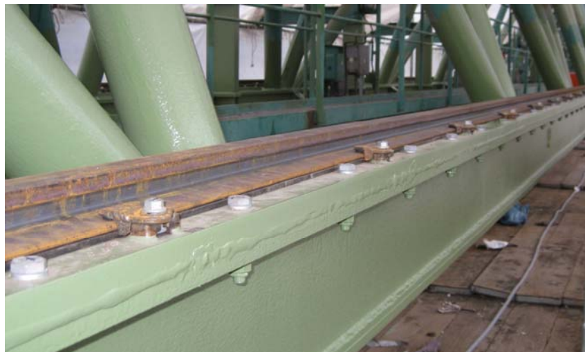
Fertige Installation mit neuer Schiene und Korrosionsschutz
