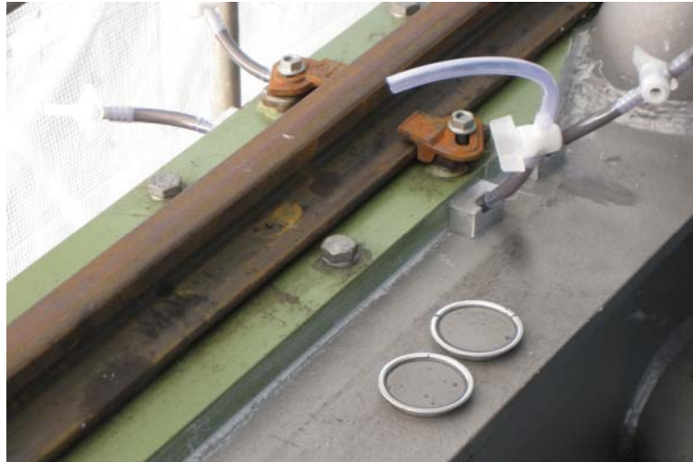
Injektion abgeschlossen – Rückmusterdeckel für Qualitätssicherung
