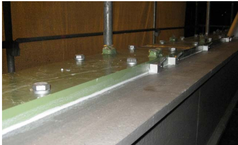
Vorbereitungen für Injektion abgeschlossen
