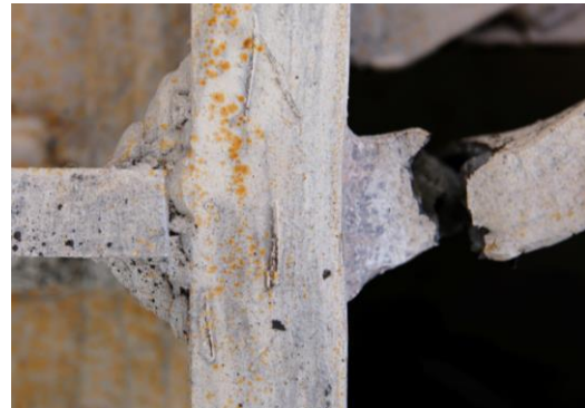
(d) West Beam Bottom Flange
