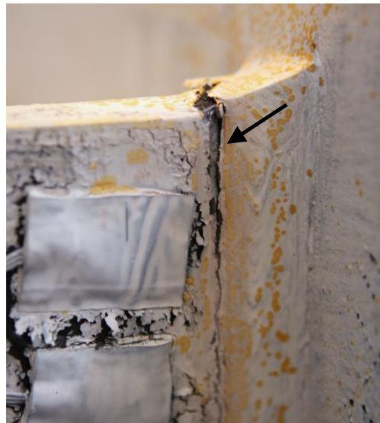
(b) Weld Tear
