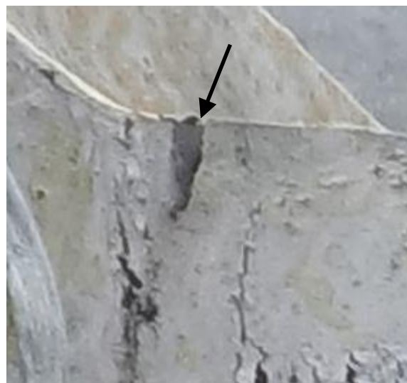
(b) Weld Tear
