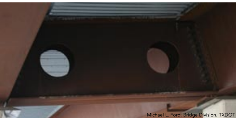
▲ ▼ Fig. 5: End diaphragm.
