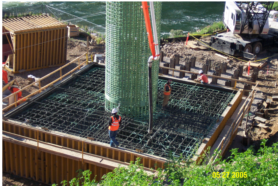
Photo 2: Footing pour at Pier 2
