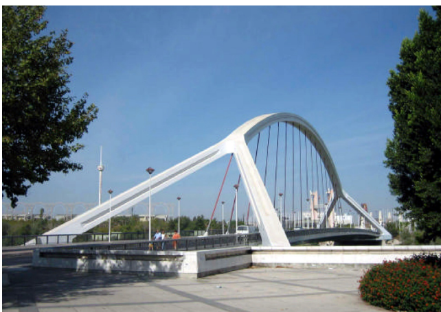
Fig. 18. Puente de la Barqueta
