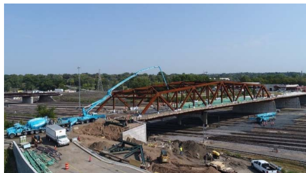
Figure 14 - Concrete Deck Pour
