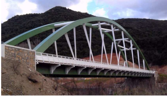
Figure 7: Pont de franchissement de l'Orb à Bedarieux – J. Berthelley (2009), span 90m [34].
